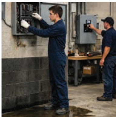
شکل ۳۲- خطر پنهان در محیط کار - برق‌گرفتگی
