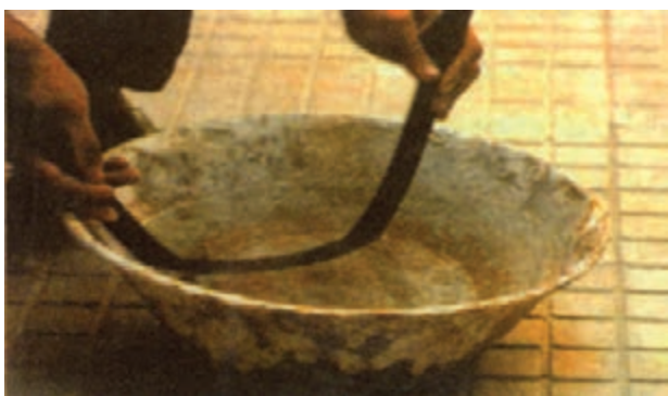
شکل ۴-۴۵ — سرد کردن لوله پس از خم کاری
