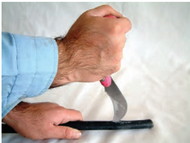
الف - نحوه‌ی غلط لخت کردن کابل
