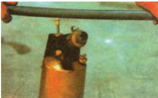
شکل ۴-۴۳ — حرارت دادن لوله ی PVC
