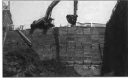
شکل ۱- ضرورت رعایت ایمنی در عملیات گودبرداری
