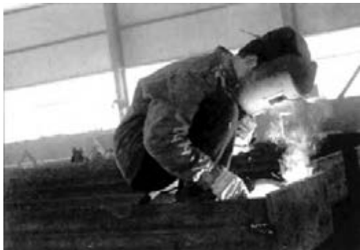
شکل ۲- جوشکاری با الکترودهای روکش دار
