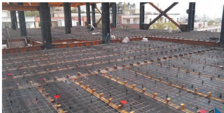
شکل ۳۲ ▲ سقف مرکب به همراه برشگیرها
