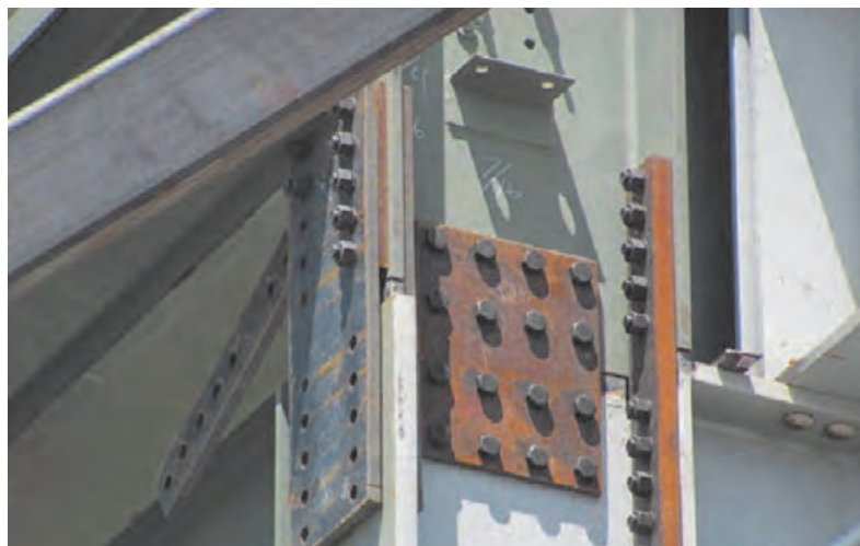
شکل ۵۷ وصله پیچی ستون
