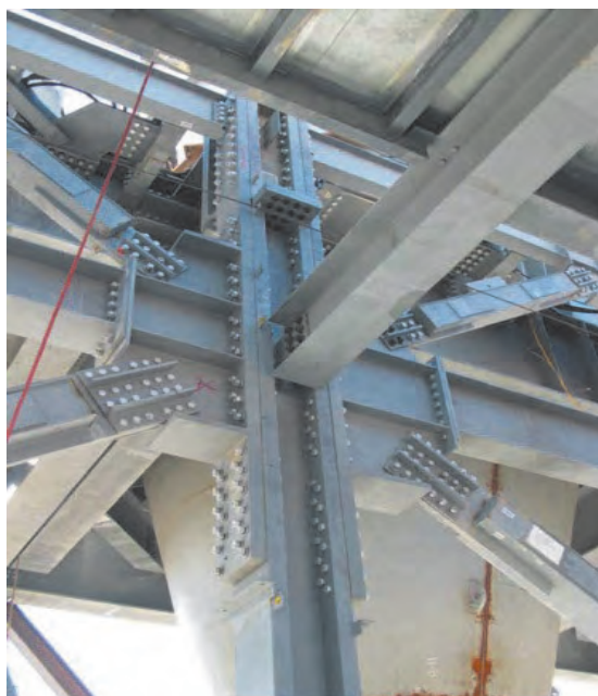
شکل ۵۱ ▲ اتصال مهاربندی
