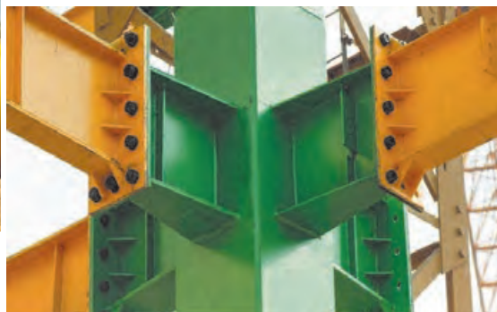
شکل ۵۰ ▲ انواع اتصال فلنجی
