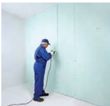
شکل ۱۰۱-۱- اجرای لایه دوم پانل‌ها
