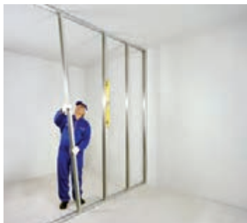
شکل ۱-۸۳- اجرای ردیف اول استادهای (به صورت شاقولی)
