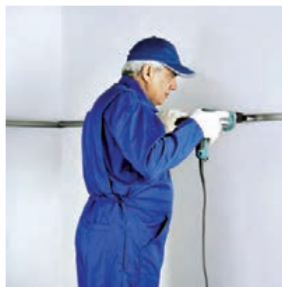
شکل ۳-۴۵- نصب سازه تراز
