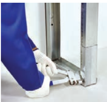
شکل ۱-۱۱۷- اتصال پایین استاد با پانچ
