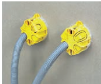
شکل ۱-۱۷۷- گیره‌ها با پانل درگیر شده و قوطی برق در جای خود محکم می‌شود.
