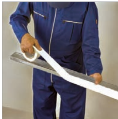
شکل ۸۵-۳- چسباندن نوار ترن فیکس بر روی سازه
