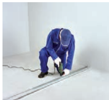
شکل ۴۳-۱- اتصال رانر به کف (سوراخ کردن رانر و کف)
