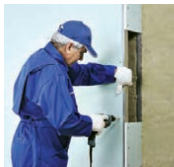
شکل ۱۰۰-۱- اجرای پانل‌ها در طرف دیگر دیوار
