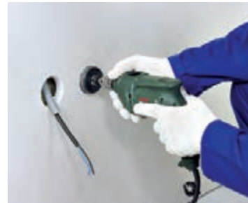
شکل ۱-۱۷۳- خروجی‌های تأسیساتی به وسیله گردبر ایجاد می‌شوند.
