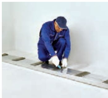
شکل ۱-۸۲- برش نوارهای عایق
