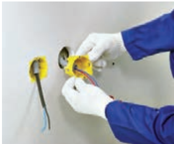
شکل ۱-۱۷۵- در حالی که گیره‌ها باز هستند، قوطی برق در محل خود قرار می‌گیرد.
