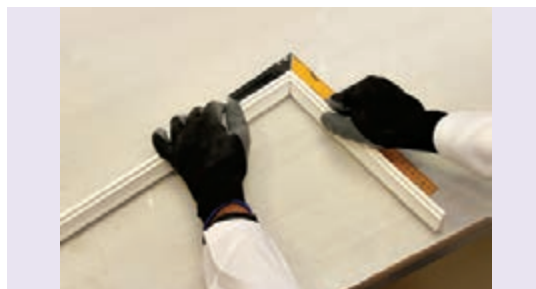
شکل ۲۲۹-۱ کنترل گونیا بودن قطعات قبل از نصب
