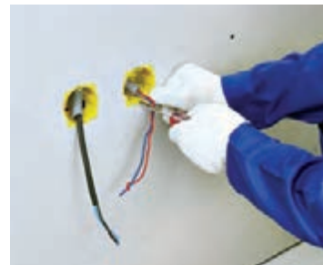
شکل ۱-۱۷۶- گیره‌ها توسط پیچ گوشتی جمع می‌شوند.
