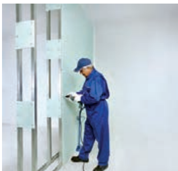
شکل ۹۸-۱- اجرای پانل‌ها در یک طرف دیوار
