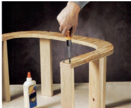
شکل ۴-۲۱- پیچ کردن قیدها به پایه
