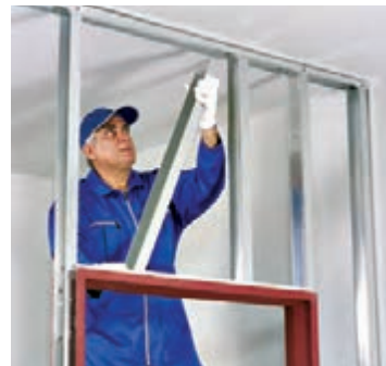
شکل ۱۳۱- استقرار استادهای کتیبه
