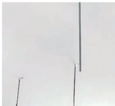
شکل ۳-۴۸- تکمیل شدن آویزها
