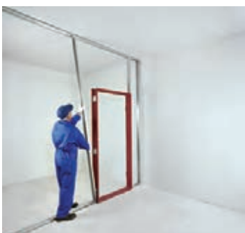
شکل ۱-۱۲۰- نصب استاد دوم
