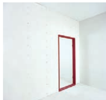
شکل ۱۴۰-۱ پانل‌گذاری در یک سمت دیوار تکمیل شده
