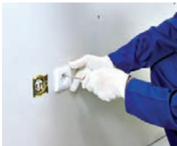
شکل ۱-۱۷۸- پس از نصب قوطی، پریز برق نصب می‌گردد.
