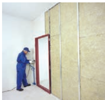
شکل ۱۴۲-۱ پیچ زنی پانل در حاشیه دور چهارچوب
