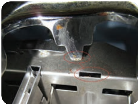
شکل ۵۸-۶ خار نر و ماده جهت اتصال
