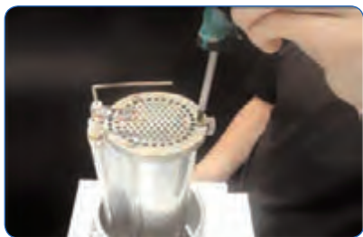
بازکردن شعله پخش کن و الکتروود و تمیزکردن
