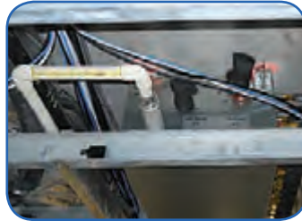
شکل ۸- نمونه اتصال لوله تخلیه به تشتک
