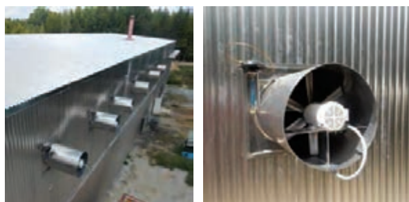
شکل ۴۳- نصب دمنده در خارج از کوره
