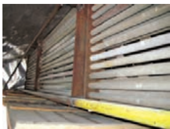
شکل ۳۸- نحوه قرارگیری کویل‌های حرارتی
