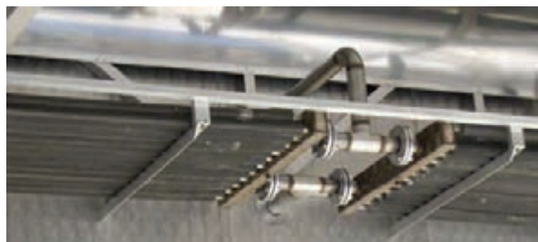
شکل ۴۱- انتقال حرارت کویل‌ها با هوای اطراف خود
