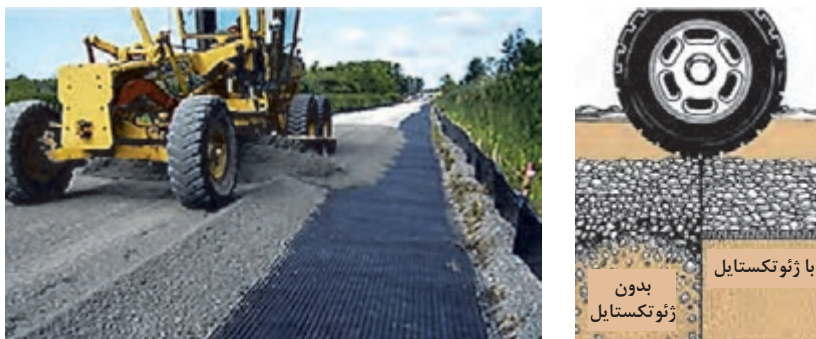
شکل ۲۵- کاربرد پارچه‌های ژئوتکستایل در زیرسازی راه
