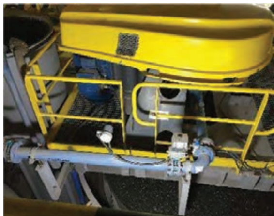
شکل ۲۷- سیستم کنترل هوا
