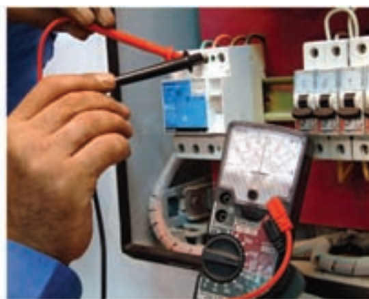
شکل ۹-۱۷- مونتاژ و تست تابلو
