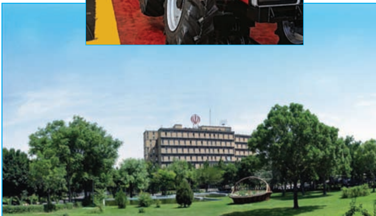
شکل ۲۹-۵- کارخانه تراکتورسازی تبریز
