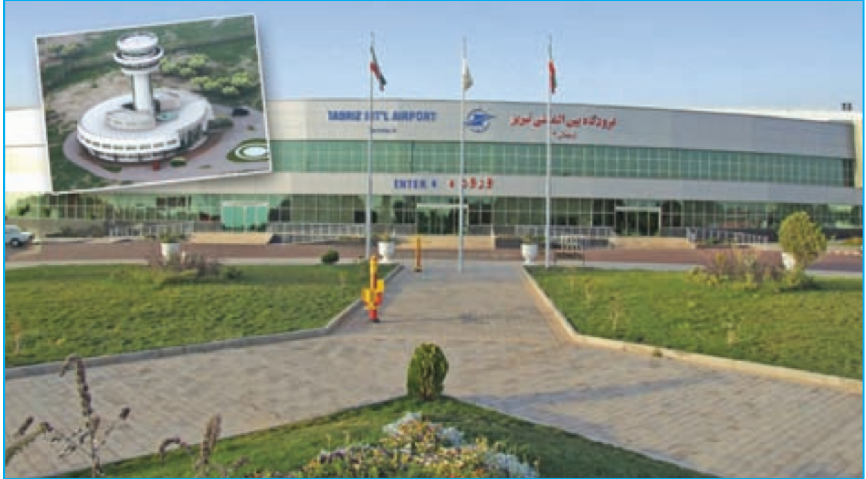
شکل ۳۳-۵- نمای از فرودگاه بین‌المللی تبریز
