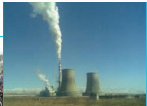
بناب- نیروگاه برق
