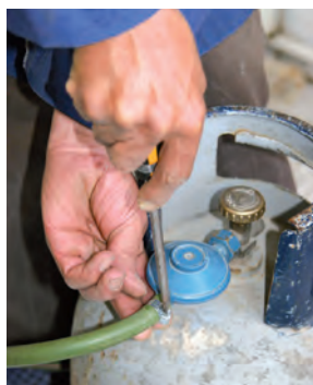
شکل ۱-۶۶ ب سفت کردن بست
