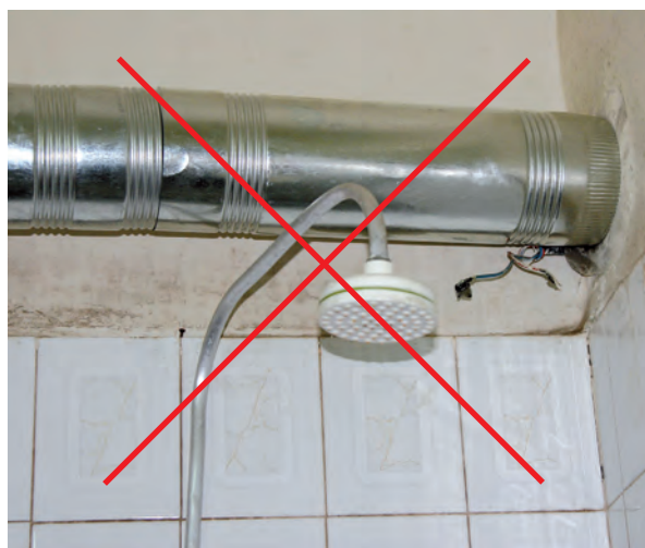
شکل ۳-۱۱ عبور غیر مجاز دودکش
