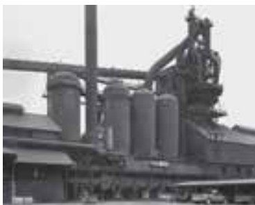
شکل ۱-۲- نمای تاسیسات یک کوره بلند
