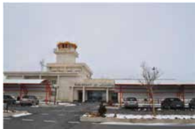
شکل ۱-۶- فرودگاه شهر اراک
