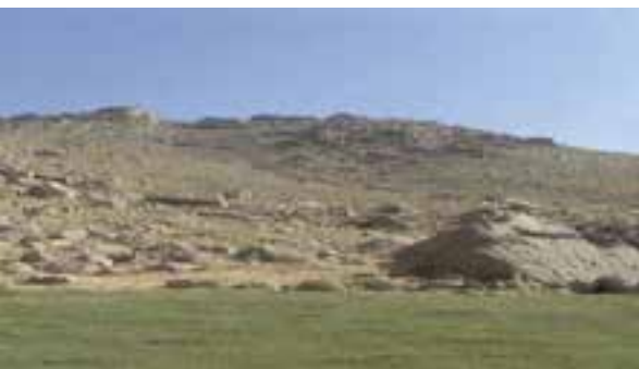
شکل ۱۳-۱ ریزش سنگ در دامنه‌ها
