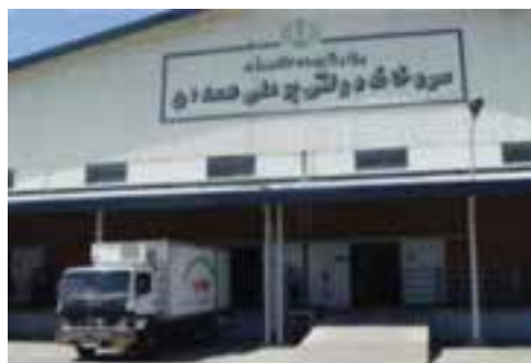
شکل ۲-۶- سردخانه بوعلی - همدان
