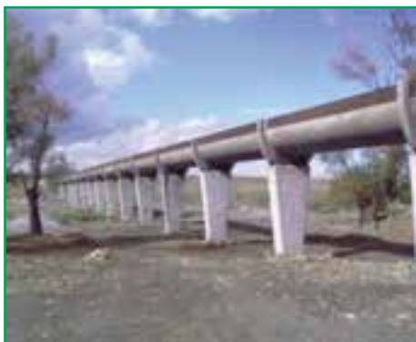
شکل ۴۵-۱- کانال انتقال آب (سیاه کمر)
