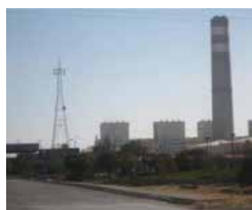
شکل ۱۹-۵- نیروگاه برق شهید مفتاح - فامنین
