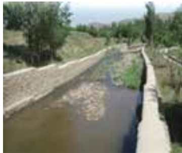
شکل ۱-۶۴- دیوار حاشیه رودخانه
