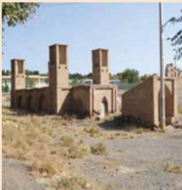
شکل ۳-۴- آب انباری در کوهپایه
