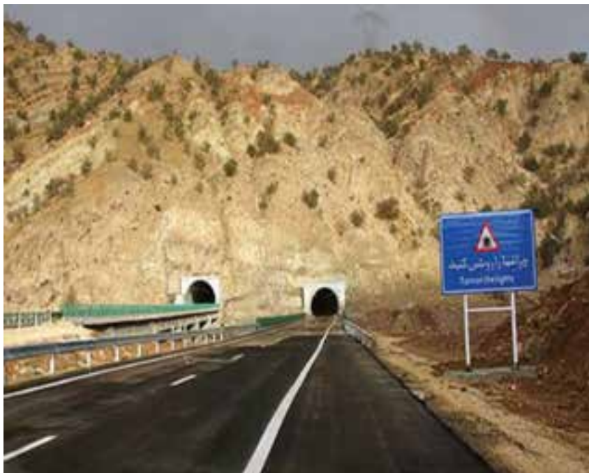
شکل ۱۲-۱۴- آزادراه خرم‌آباد - پل زال
