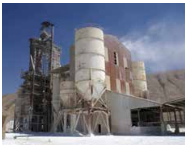
شکل ۳-۱۴- کارخانه آهک هیدراته پلدختر
