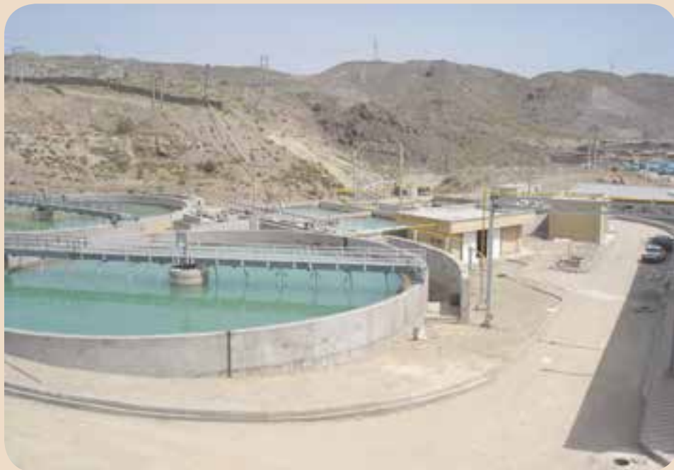
شکل ۶۰-۱- تصفیه خانه مجتمع مس سرچشمه
