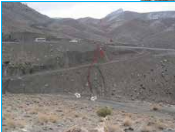
شکل ۱۶-۱- شکاف ناشی از زلزله داهوئیه زرنده سال ۱۳۸۳
