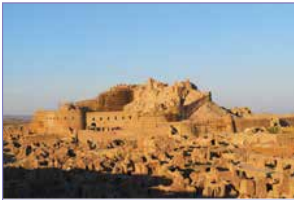
شکل ۳۱-۵- ارگ بم در حال بازسازی
