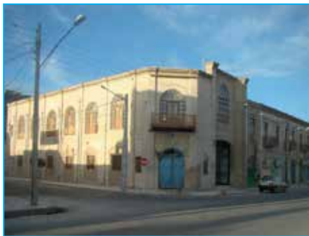
شکل ۷-۱۲- ساختمان دادگستری قدیم
