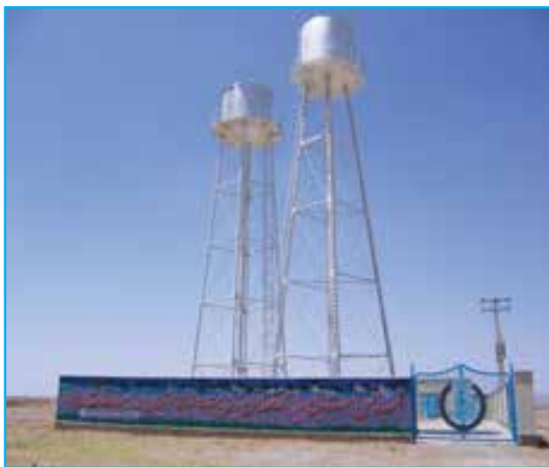
شکل ۱۰-۱۴- اجرای طرح آبرسانی بهداشتی روستایی
