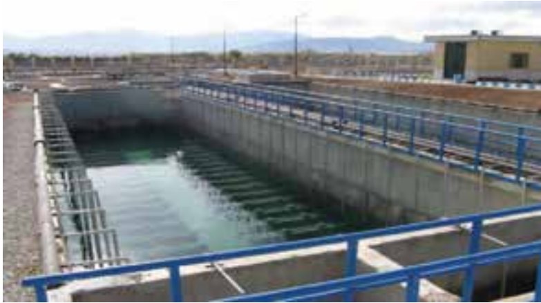
تصویر ۱-۵- تصفیه خانه شهرک صنعتی شهرکرد
