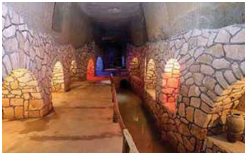
شکل ۱۵-۵- مظهر قنات‌های زیرزمینی کاریز، کیش
