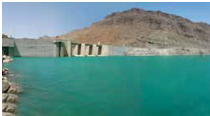
شکل ۱۹-۶- مهار آب های سطحی
