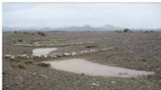
عملیات آبخیزداری احداث بندهای خشک‌چین شکل ۵۳-۱- مجموعه عملیات آبخیزداری
