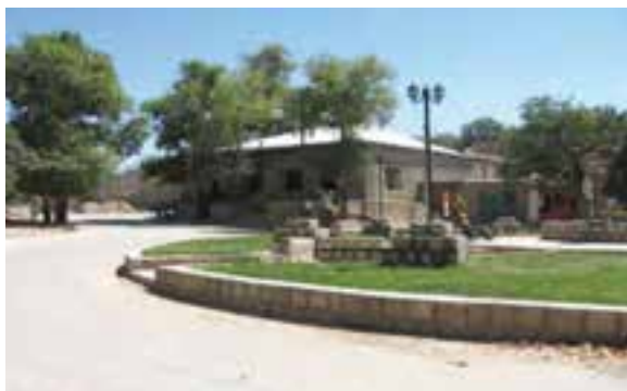
شکل ۲۲-۲- اجرای طرح هادی روستای بدرانلو بجنورد
