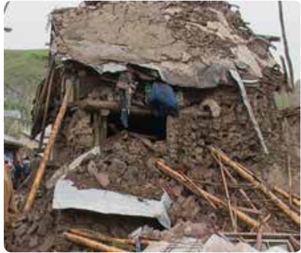
شکل ۲-۵- زلزله سال ۱۳۸۳- طالقان
