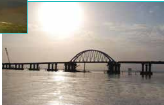
شکل ۱۰-۵- بزرگراه شهید کلانتری بر روی دریاچه ارومیه
