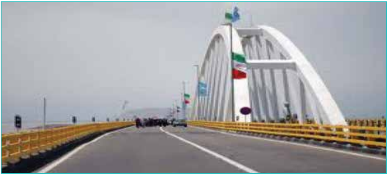
شکل ۶-۶- پل میان گذر دریاچه ارومیه
