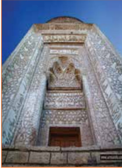
شکل ۲۴-۴- نمایی از سه گنبد ارومیه
