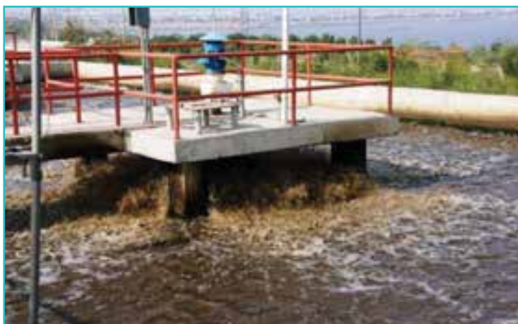
شکل ۵-۶- تصفیه‌خانه فاضلاب ارومیه
