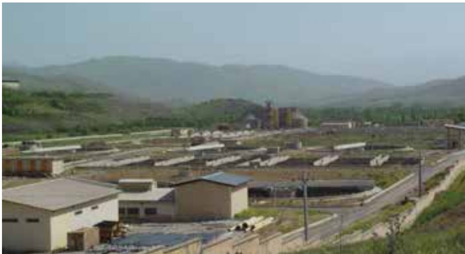
شکل ۷۳-۱- تصفیه‌خانه فاضلاب سنندج
