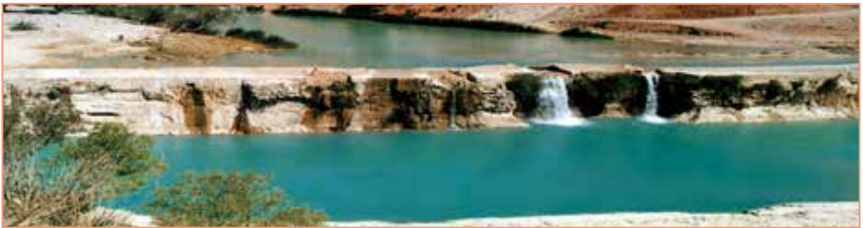
شکل ۱۰-۹- بند بهمن در استان فارس از ابداعات ایرانیان برای بهره‌گیری از آب‌های سطحی (زمان تقریبی ساخت ۲۰۰۰ سال قبل)
