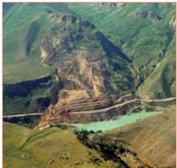
شکل ۲۳-۶ - تشکیل دریاچه به وسیله سد طبیعی از لغزش دامنه ها در منطقه آب اسک جاده هراز
