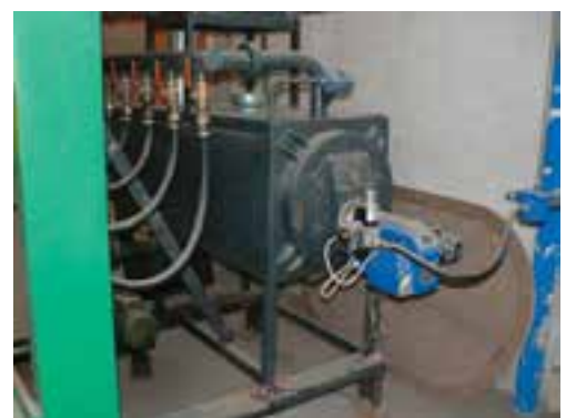
شکل ۱۱۹-۱۵- کنترل مشعل و دیگ داغ‌کننده روغن.
