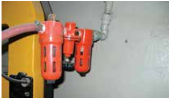
شکل ۱۴۸-۱۶- فیلتر رطوبت هوای فشرده.
