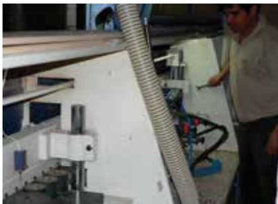
شکل ۱۸۱-۱۶- ستون فلز استقرار قسمت فوقانی اسکلت ایستگاه.
