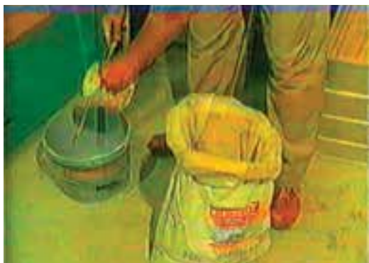
شکل ۶۰-۱۵- مل کردن پودر چسب در آب.
