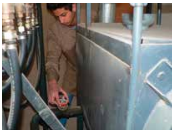
شکل ۱۳۸-۱۵- کنترل شیر فرامپی (روغن از مخزن دیگ روغن).
