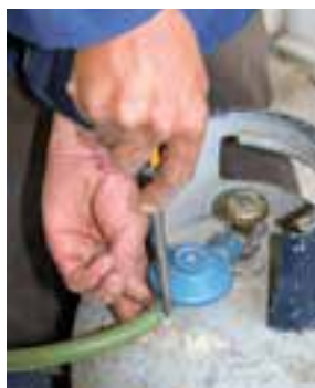
شکل ۱-۶۶ ب سفت کردن بست
