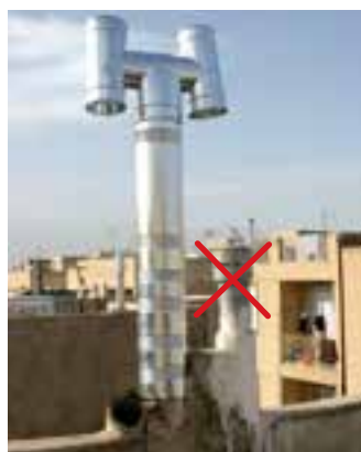
شکل ۱-۴۰ دهانه خروجی دودکش بر روی بام با کلاهک H
