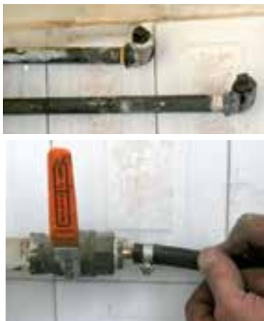
شکل ۱-۵ لوله‌های آب سرد، آب گرم و شیلنگ گاز در محل نصب آب گرم کن.
