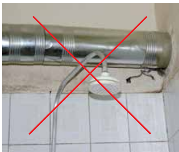
شکل ۳-۱۱ عبور غیر مجاز دودکش
