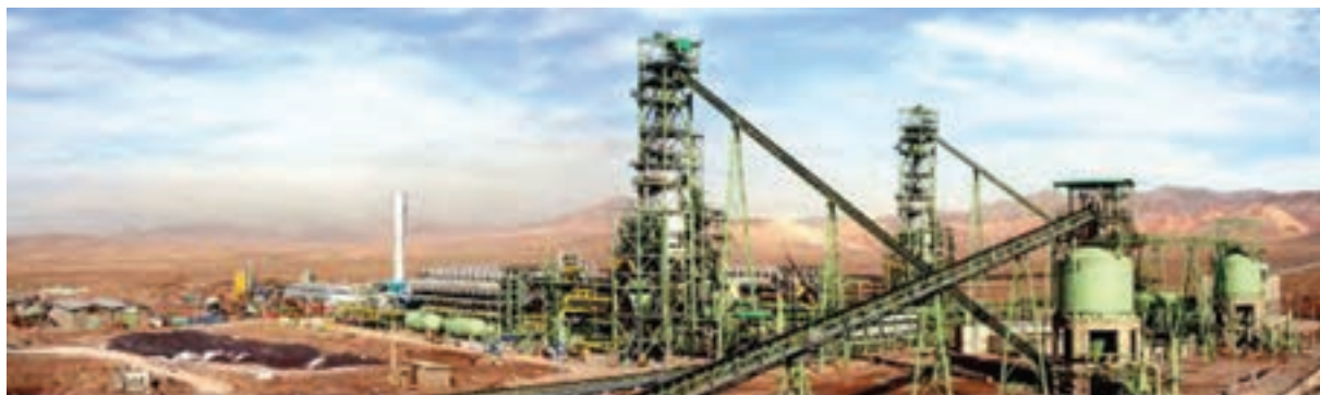
شکل ۳-۶- نمای از کارخانه فولاد خراسان - نیشابور
