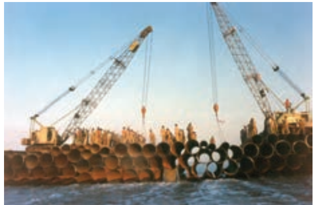
شکل ۱۵-۴- پل بعثت در داخل اروند رود «سند افتخار نیروهای مهندسی رزمی جهادسازندگی خراسان»
