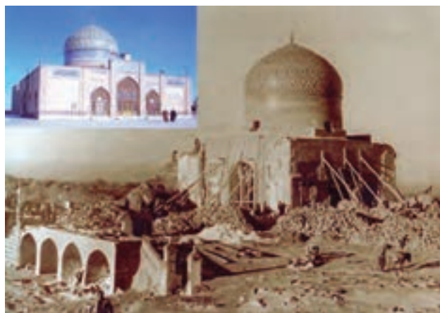
شکل ۱۴-۱- زلزله سال ۱۳۴۷ کاشک گناباد
