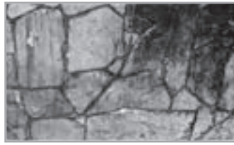
شکل ۴-۷- استفاده از سنگ لاشه
