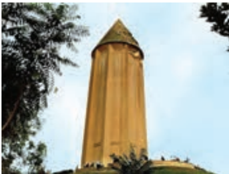
شکل ۴-۶- بنای گنبد قابوس بلندترین برج آجری دنیا با ۵۳ متر ارتفاع
