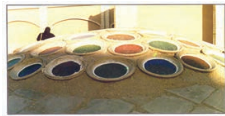
شکل ۲-۱۲- استفاده از گلجام در بازسازی سقف حمام
