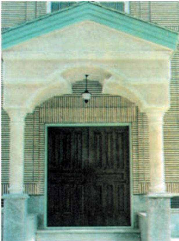
شکل ۲۰-۵- ستون‌سازی - سرستون‌سازی - قوس‌سازی سه کمانه - ابزارزنی - سیمان‌بری
