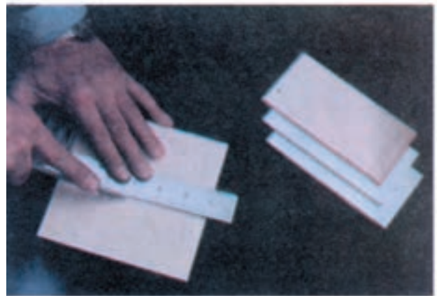
شکل ۱۲-۶- نحوه‌ی خط اندازی پشت کاشی جهت دو نیمه کردن کاشی
