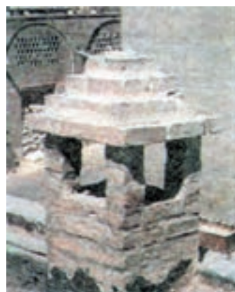
شکل ۳-۶- دودکش و هواکش در ساختمان
