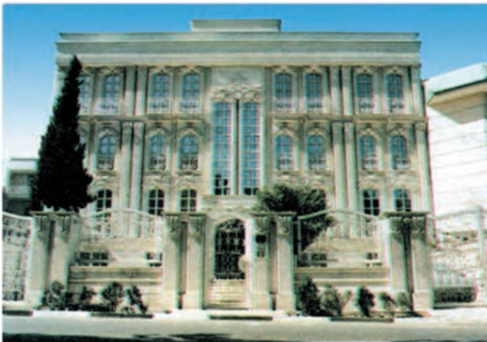
شکل ۲۱-۵- اجرای سیمان‌بری باروک
