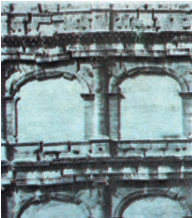
شکل ۳۵-۱- واکنش قوس نیم دایره از ناحیه‌ی تیزه و دو شانه
