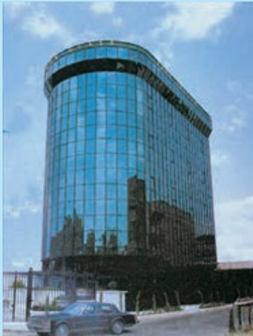
شکل ۳۷-۱۴- دسترسی به عایق حرارتی و صدا و داشتن ایمنی و محافظت از اشعه‌ی ماورای بنفش با دوجداره کردن شیشه و اکسید فلز روی آن
