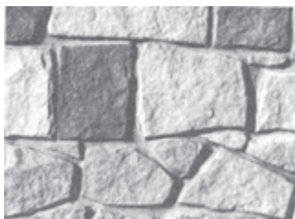
شکل ۱۱-۲- دیوار با سنگ چندوجهی سرتراش رجدار
