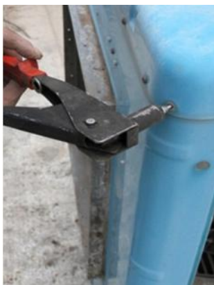
شکل - اتصال بدنه کولر با پرچ
