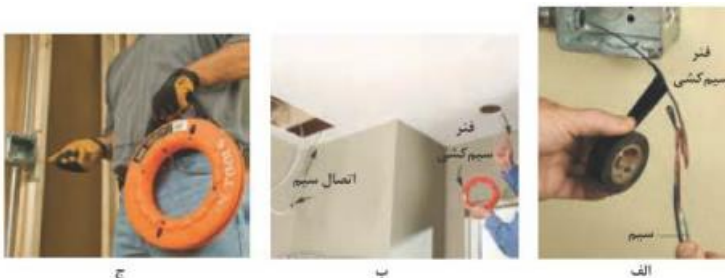
شکل ۳۷- چگونگی استفاده از فنر سیم‌کشی
