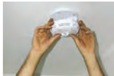
شکل ۱۵-۱ قرار دادن یک نوع آشکارساز روی پایه
