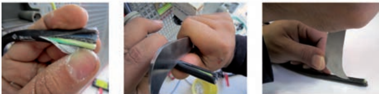
شکل ۲-۲۲ - بریدن و لخت کردن کابل
