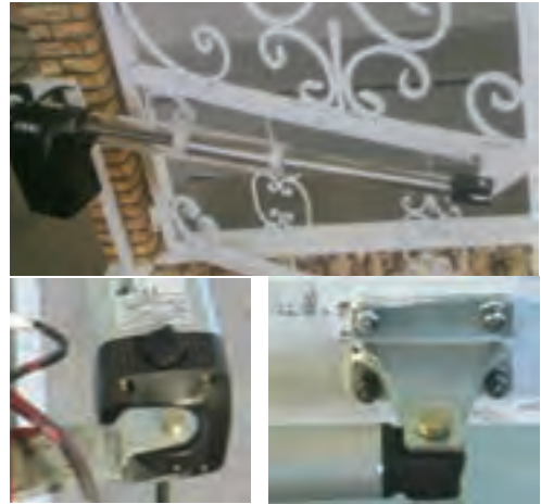
شکل ۴-۴۸ محل اتصال موتور به چارچوب در و لنگه در
