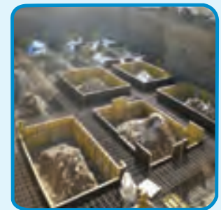
شکل ۳-۳۱- قالب فایبرگلاس برای اجرای پی
