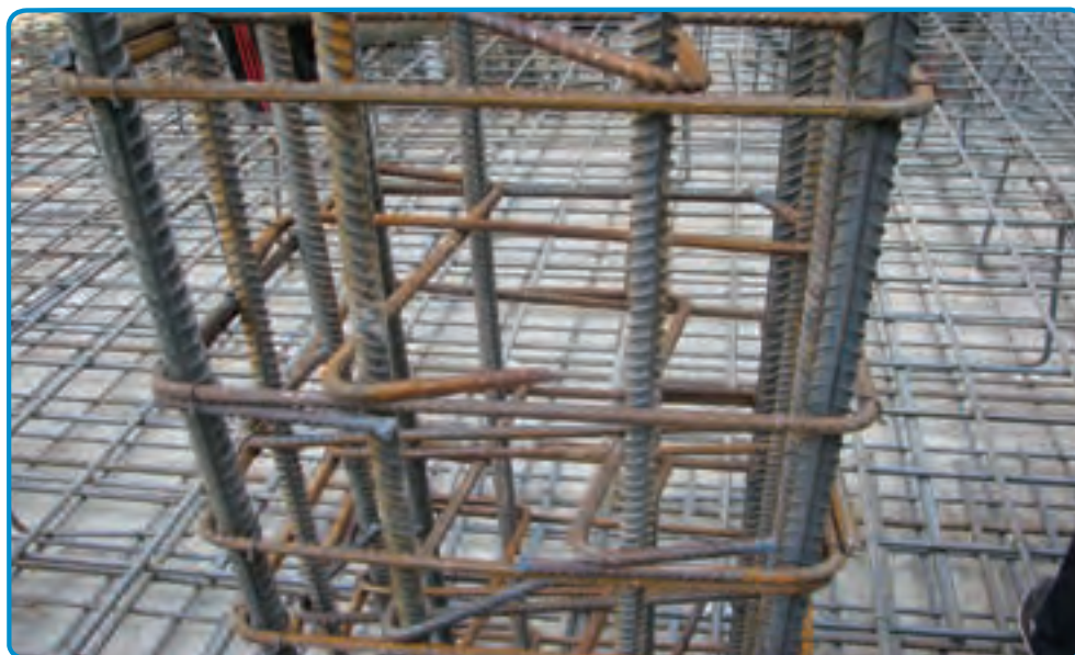
شکل ۵۰-۳- کاربرد سنجاقک در میلگرد گذاری ستون
