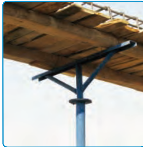
شکل ۳-۲۱- استفاده از شمع‌های فلزی جهت نگهداری قالب‌ها
