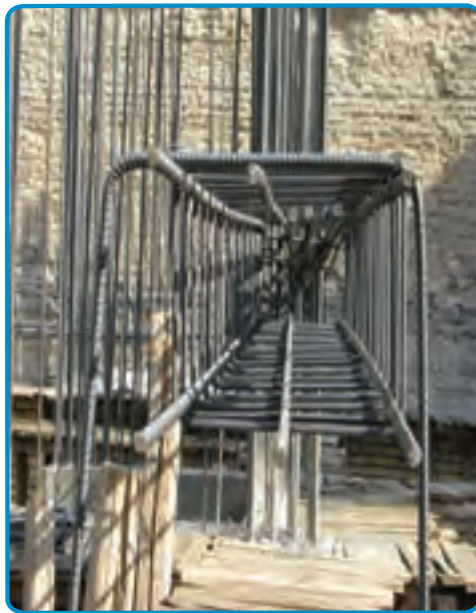
شکل ۳-۴۵- میلگرد طولی در تیر
