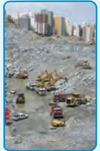
شکل ۳-۷- گودبرداری در زمین‌های نامحدود
