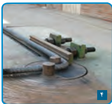
شکل ۶۴-۳- خم کردن میلگرد
