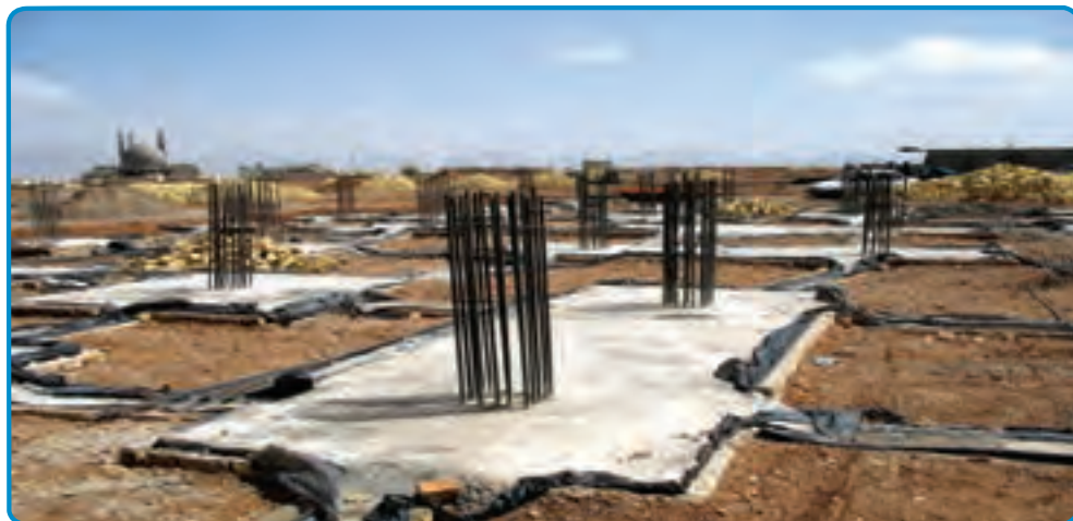
شکل ۱۰-۳- استفاده از پلاستیک در پی
