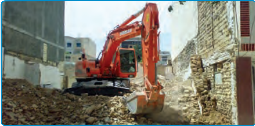
شکل ۳-۲- خاکبرداری با ماشین
