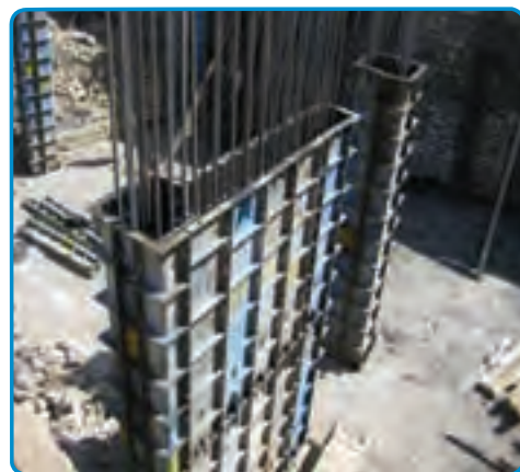
شکل ۳-۳۵- قالب فلزی برای اجرای دیوار بتنی
