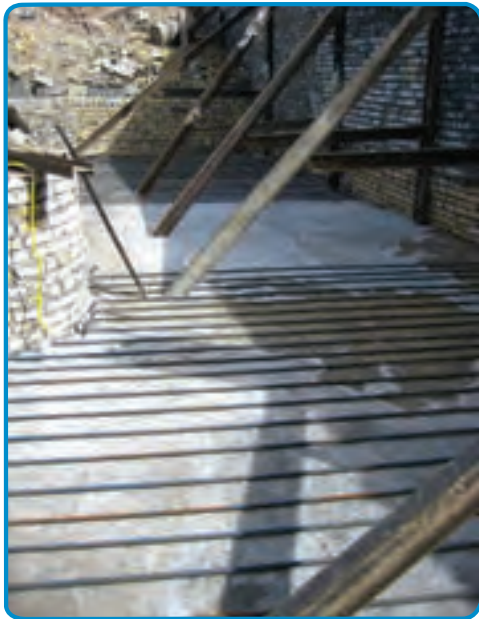
شکل ۳-۴۶- میلگرد طولی کف پی
