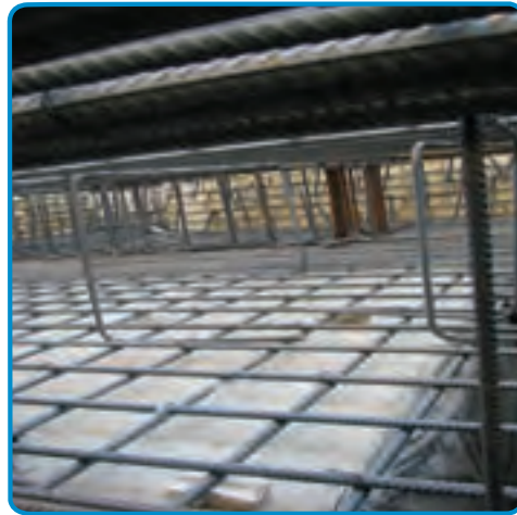
شکل ۳-۵۳ - استفاده از خرک در میلگرد گذاری پی
