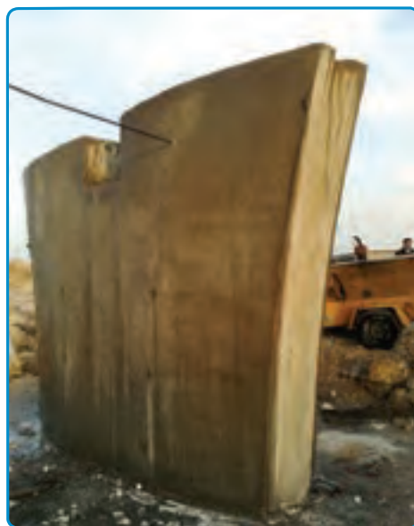
شکل ۳-۴۲- قالب برداری
