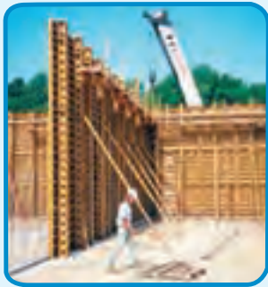
شکل ۱۹-۳- فایبر گلاس برای اجرای دیوار بتنی
