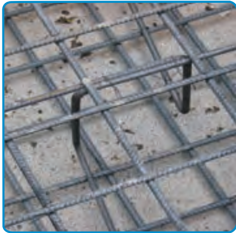
شکل ۳-۵۳ - استفاده از خرک در میلگرد گذاری پی
