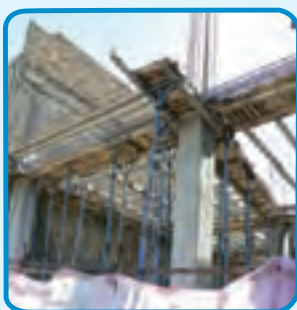
شکل ۳-۳۹- استفاده از قالب چوبی برای اجرای تیر
