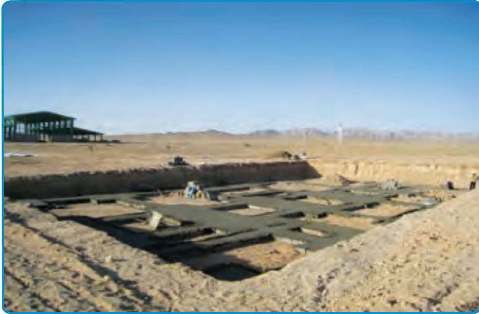
شکل ۳-۶- گودبرداری در زمین‌های نامحدود
