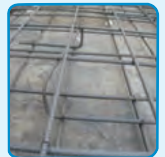
شکل ۳-۵۵ - استفاده از خرک در میلگرد گذاری دال
