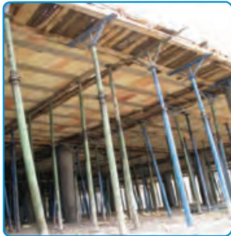
شکل ۳-۲۱- استفاده از شمع‌های فلزی جهت نگهداری قالب‌ها
