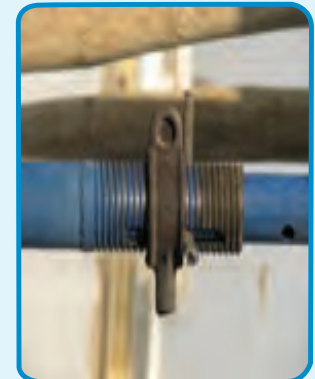
شکل ۳-۲۳- سوراخ‌های روی شمع فلزی جهت تعیین ارتفاع مناسب
