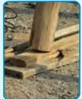
شکل ۳-۲۵- استفاده از گوه جهت تنظیم ارتفاع
