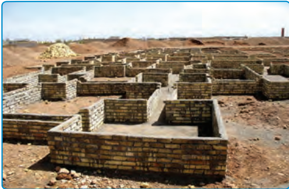
شکل ۱۵-۳- استفاده از قالب آجری برای اجرای پی
