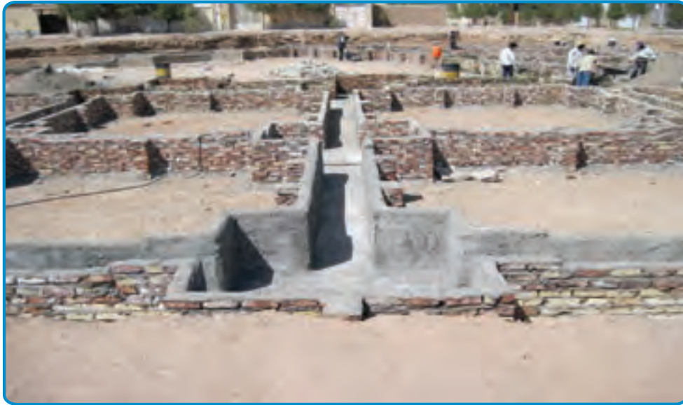
شکل ۳-۲۹- قالب آجری برای اجرای پی
