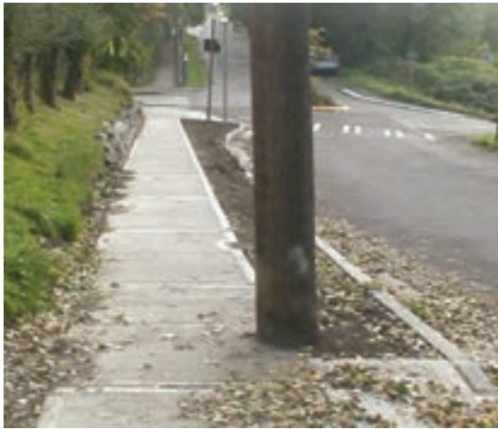
▲ شکل ۳-۴۰ به کارگیری قطعات مجزا در کف‌سازی
