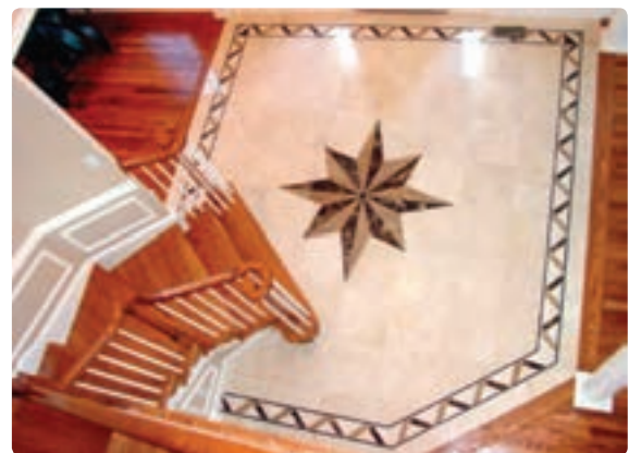
▲ شکل ۱-۵ استفاده از سنگ در فضای پذیرایی
