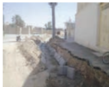
▲ شکل ۳-۳۲ آماده سازی در کف جوی پشت جدول
