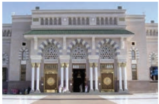
▲ شکل ۴-۷۰ قوس های سنگی (مسجد پیامبر)
