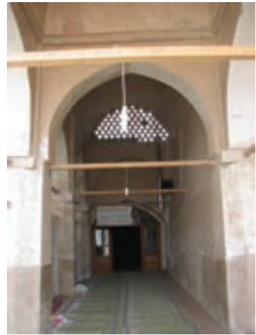
▲ شکل ۴-۷۲ کاربرد چوب در ساخت قوس‌ها
