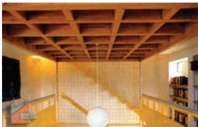
◀ شکل ۱-۵۹- سقف کاذب مشبک چوبی
