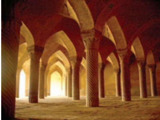
▲ شکل ۴-۶۹ قوس های آجری (مسجد وکیل شیراز)
