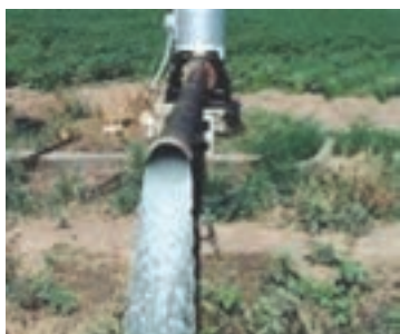
▲ شکل ۹-۲ انتقال آب از طریق لوله
