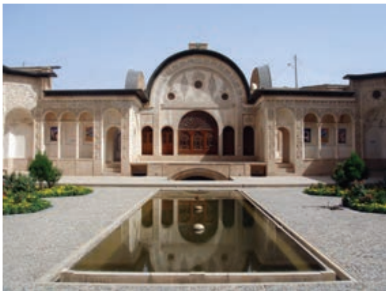
شکل ۲۶-۴ خانه طباطبایی‌ها در کاشان (قوس نیم دایره)
