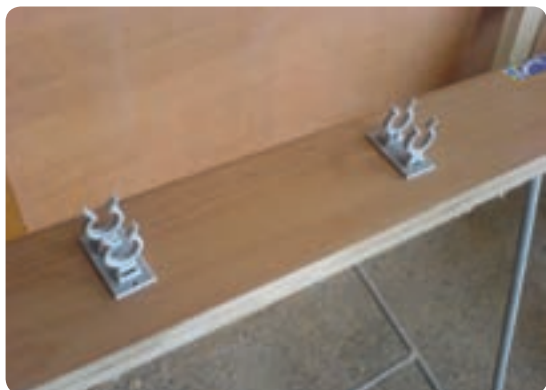
شکل ۶-۶۵ اتصال کلیس پاسنگ به پایه کابینت
