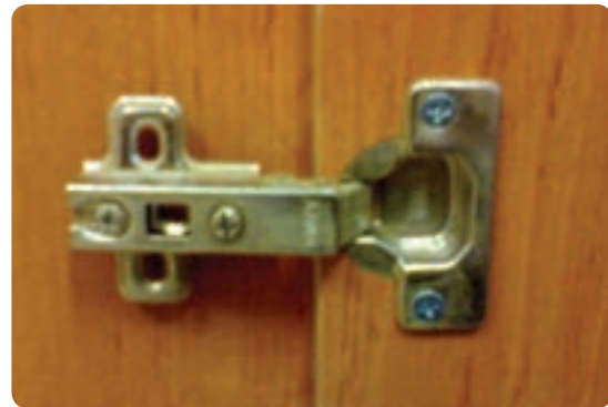
شکل ۸۵-۶ نصب کاسه لولا روی در کابینت
