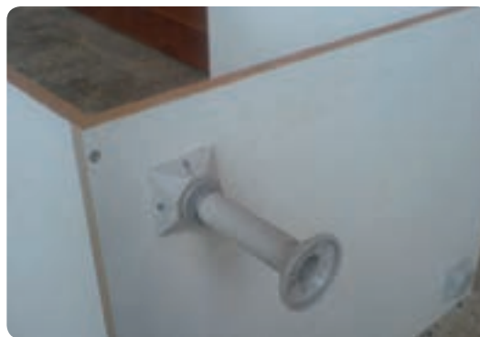
شکل ۶-۱۱۵ پایه نصب شده زیر کابینت
