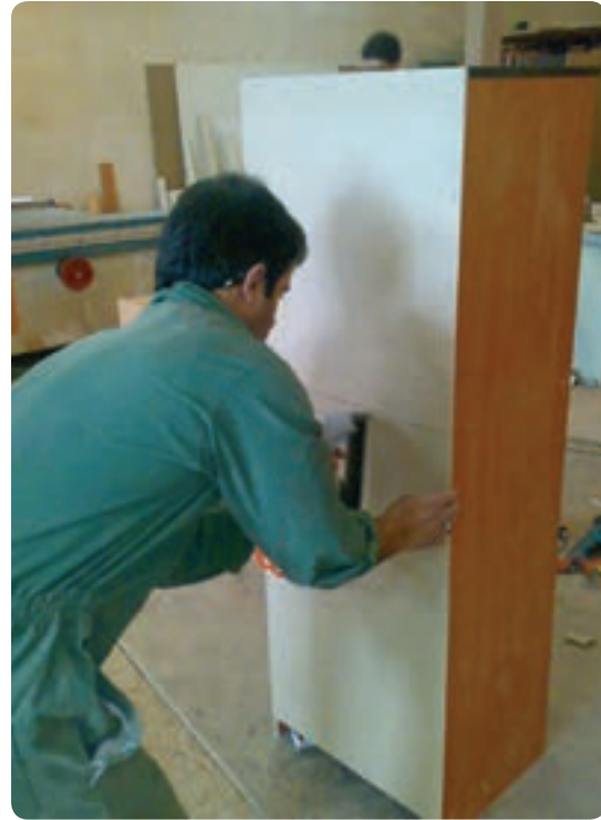
شکل ۱۲۱-۶ نصب پشت بند کابینت
