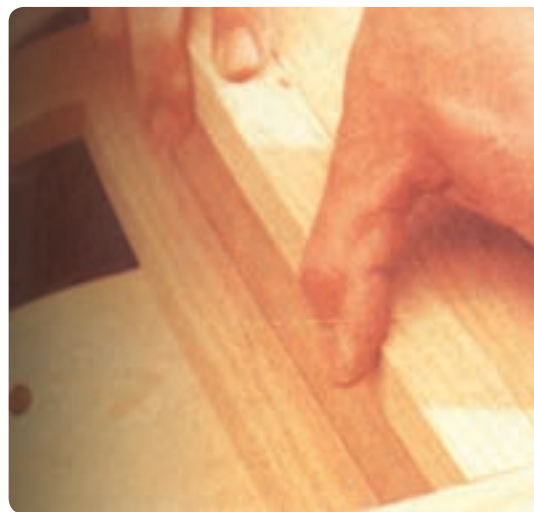
شکل ۶-۱۵۶ نصب ریل هدایت کشو
