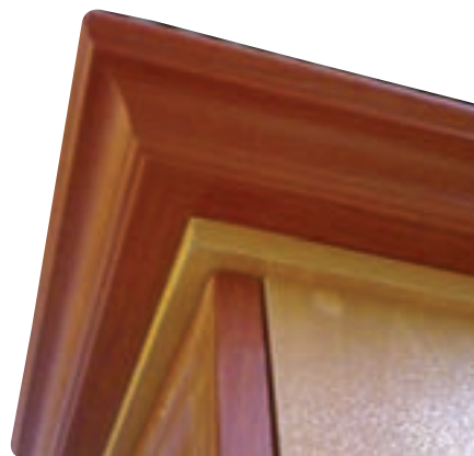
شکل ۶-۵ قرارگیری بدنه کابینت بین سقف و کف کابینت
