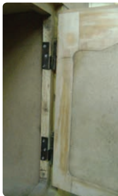
شکل ۶-۸۸ در قاب تنکه‌ای با لولای قابل‌مهای
