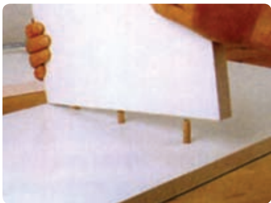
شکل ۶-۷۴ اتصال دوپل جهت مونتاژ کابینت
