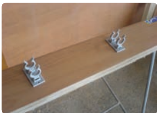
شکل ۶-۶۵ اتصال کلیس پاسنگ به پایه کابینت
