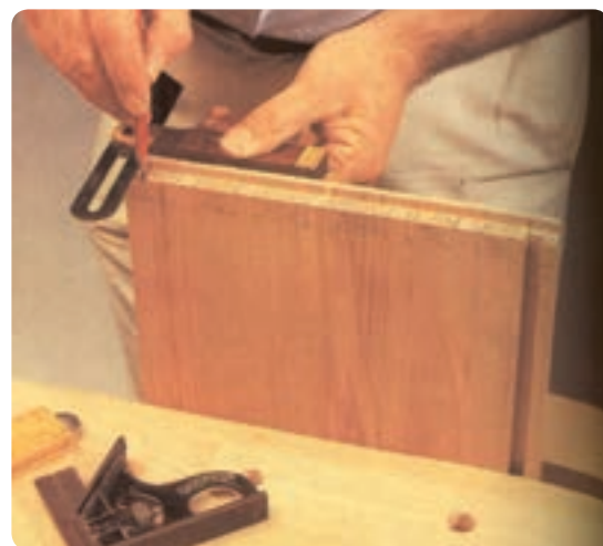
شکل ۶-۱۳۶ خط‌کشی اتصال دم‌چلچله دورو مخفی
