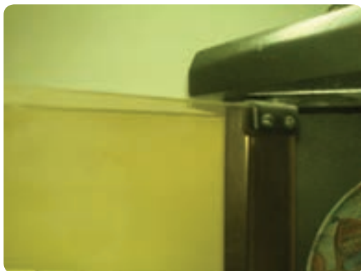
شکل ۶-۴۰ در شیشه ای با لولای پاشنه ای
