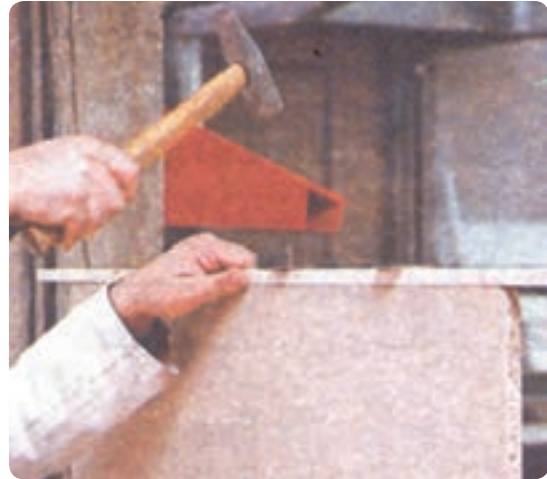
شکل ۷۸-۶ نصب زهوار چوبی لبه چسبان
