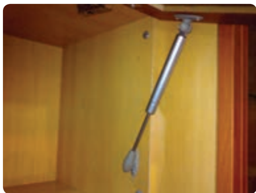
شکل ۶-۳۶ در کابینت با درجه یا نگه‌دارنده پمپی
