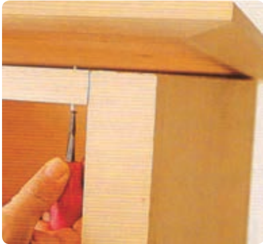
شکل ۶۹-۸ بستن صفحه روی کابینت
