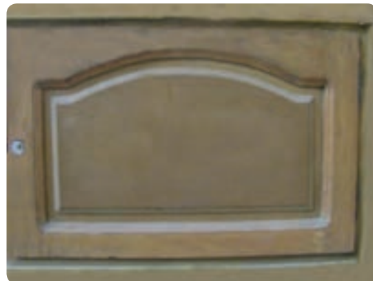
شکل ۶-۸۷ در قاب و تنکه‌ای کابینت
