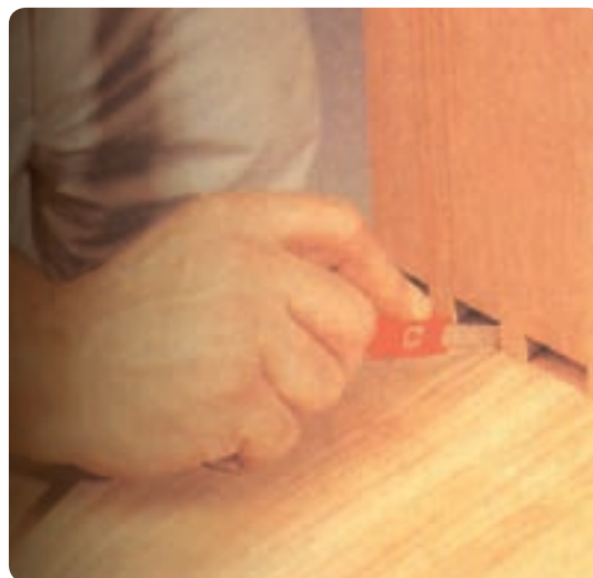
شکل ۶-۱۳۸ خط‌کشی جای فاق روی قطعه دیگر
