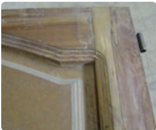
شکل ۶-۸۹ ابزار زدن قاب و تنکه
