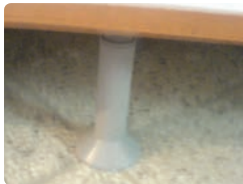
شکل ۶-۶۴ پایه نصب شده در زیر کابینت
