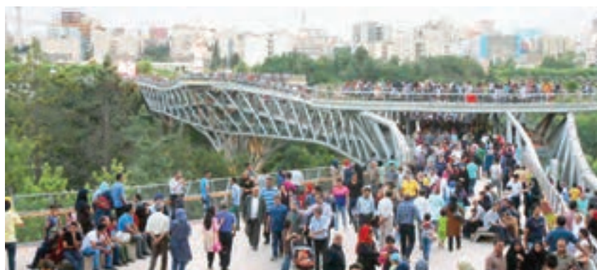
پل طبیعت - تهران
