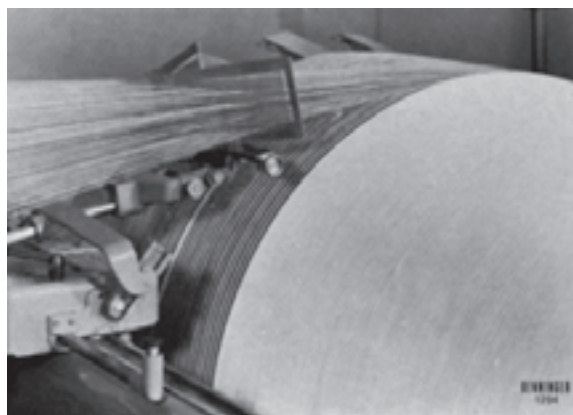
شکل ۴-۲- ساپورت ماشین چله‌پیچ بخشی
