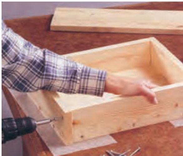
شکل ۲۲- اتصال جعبه با پیچ
