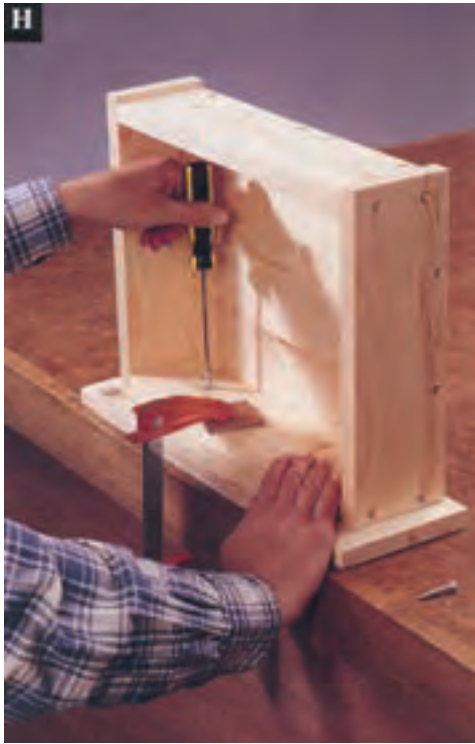
شکل ۲۴- اتصال در جعبه‌ی بیرونی بر روی جعبه‌ی داخلی به کمک چسب و پیچ
