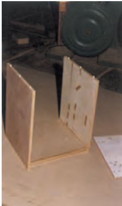
شکل ۲۰- مونتاژ کف و بدنه
