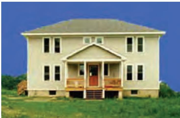
شکل ۱۶-۱- نمای ساختمان اجرا شده
