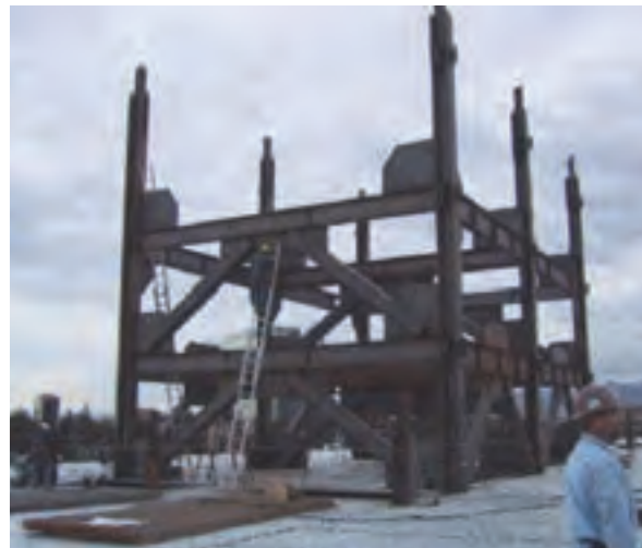
شکل ۳-۸ - تصویر یک سازه فلزی
